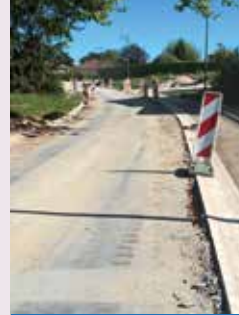
Pose des pavés
