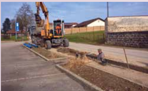
Remplacement du réseau d'eau potable
